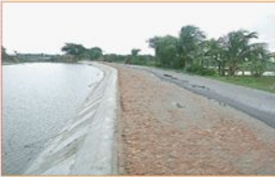
পানির ঢেউয়ের ক্ষতিগ্রস্ত অংশ মেরামতের পর কেশবপুর-কাটাখালী, নেহালপুর সড়ক, কেশবপুর, যশোর।
