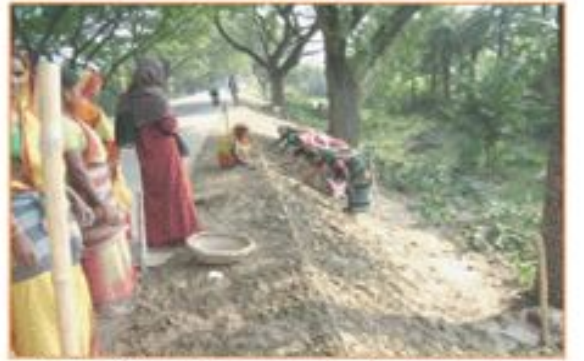
এলসিএস মহিলা দ্বারা পাকা সড়কের ক্ষতিগ্রস্ত সোতার ও প্রোপের নিয়মিত রক্ষণাবেক্ষণ করা হচ্ছে।
