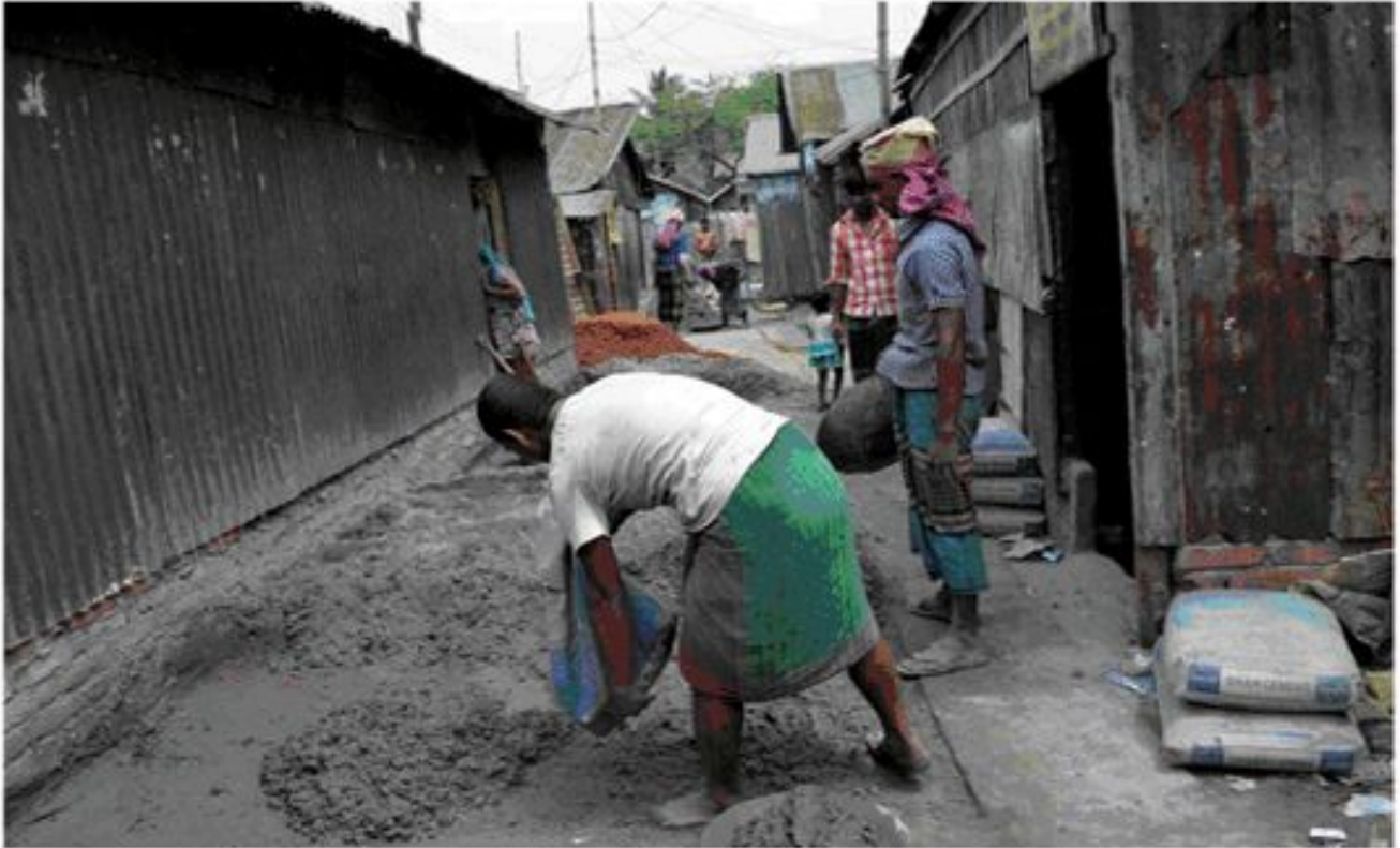
ঢাকার কড়ইলে কমিউনিটির উদ্যোগে ফুটপাথ নির্মাণ কাজ চলছে
