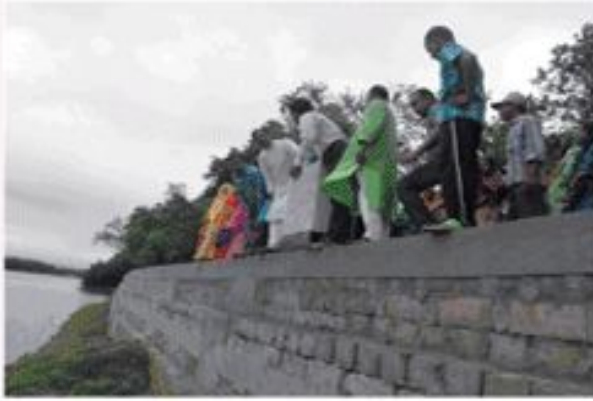
হাওরের ঢেউ/ বন্যা থেকে গ্রামের বাড়ীঘর রক্ষা করার জন্য কংক্রিট ব্লক দ্বারা নির্মিত গ্রাম প্রতিরক্ষা বাঁধ মাননীয় সংসদ সদস্য পরিদর্শন করছেন, তাহিরপুর, সুনামগঞ্জ।
