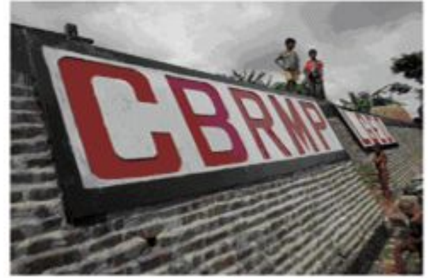
হাওরের ঢেউ/ বন্যা থেকে গ্রামের বাড়ীঘর রক্ষা করার জন্য ইট দ্বারা নির্মিত গ্রাম প্রতিরক্ষা দেওয়াল, তাহিরপুর, সুনামগঞ্জ।
