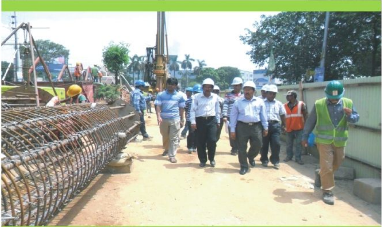
এলজিইডি'র প্রধান প্রকৌশলী জনাব মোঃ ওয়াহিদুর রহমান মগবাজার-মৌচাক (সমন্বিত) ফ্লাইওভারের পাইলিং কাজ পরিদর্শন করছেন। এসময়ে তার সাথে প্রকল্প পরিচালক জনাব মোঃ নাজমুল আলমসহ প্রকল্পের প্রকৌশলীগণ ও উপস্থিত ছিলেন।
