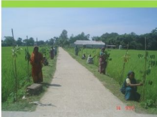
নির্মিত আরসিসি রোডের পাশে লেংথ পারসন ও নারী সংগঠনের সদস্যরা বৃক্ষরোপণ করে পরিচর্যা করছেন। বিশ্বম্ভরপুর, সুনামগঞ্জ
