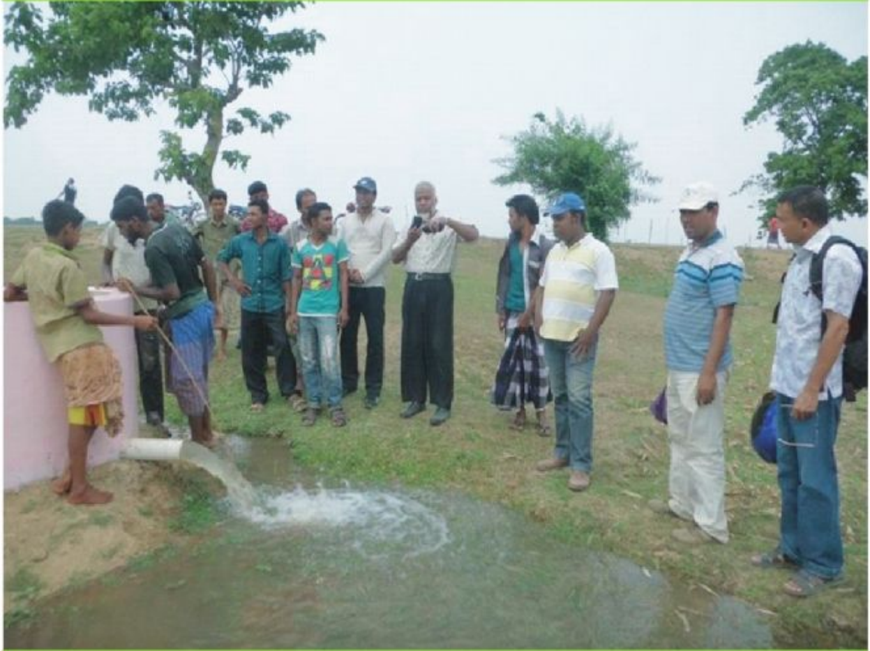
বারিড পাইপের মাধ্যমে সেচ সুবিধা পরিদর্শন করছেন প্রকল্প পরিচালক, সিবিআরএমপি, এলজিইডি ।
