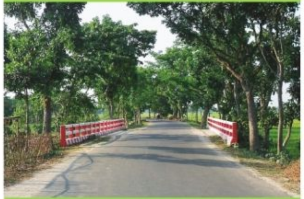
সড়ক এবং কালভার্ট রক্ষণাবেক্ষণের পর ধুনট - মথুরাপুর জিসি সড়ক, ধুনট, বগুড়া।
