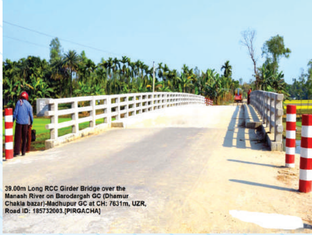
৩৯মিটার দীর্ঘ RCC Girder Bridge মেরামত। [রক্ষণাবেক্ষণের পর], উপজেলাঃ পীরগাছা, জেলাঃ রংপুর।
