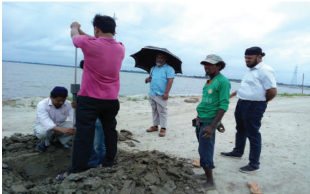
DCP এর সাহায্যে Sub-grade layer মাটির Bearing Capacity নির্ণয় করা হচ্ছে।
