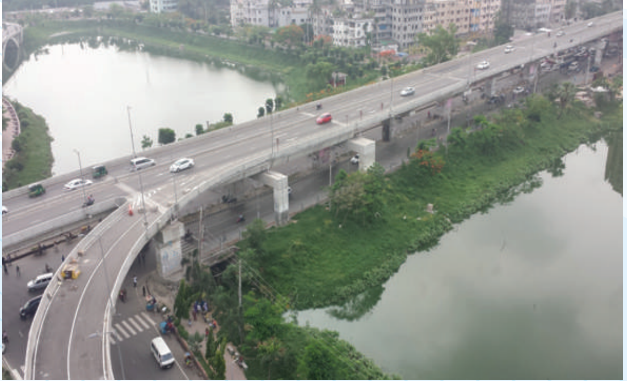
মগবাজার-মৌচাক ফ্লাইওভার এর এফডিসি ইন্টারসেকশন
