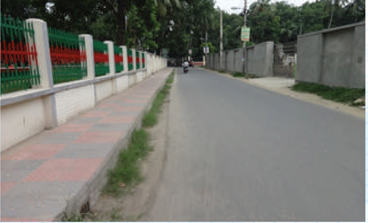
সড়ক, ড্রেন ও ফুটপাথ নির্মাণ, কুমিল্লা সিটি কর্পোরেশন।
