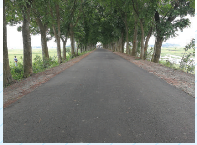
কুচিয়ামোরা আরএন্ডএইচ-শেখরনগর জিসি সড়ক। [রক্ষণাবেক্ষণের পর], উপজেলাঃ সিরাজদিখান, জেলাঃ মুন্সিগঞ্জ।
