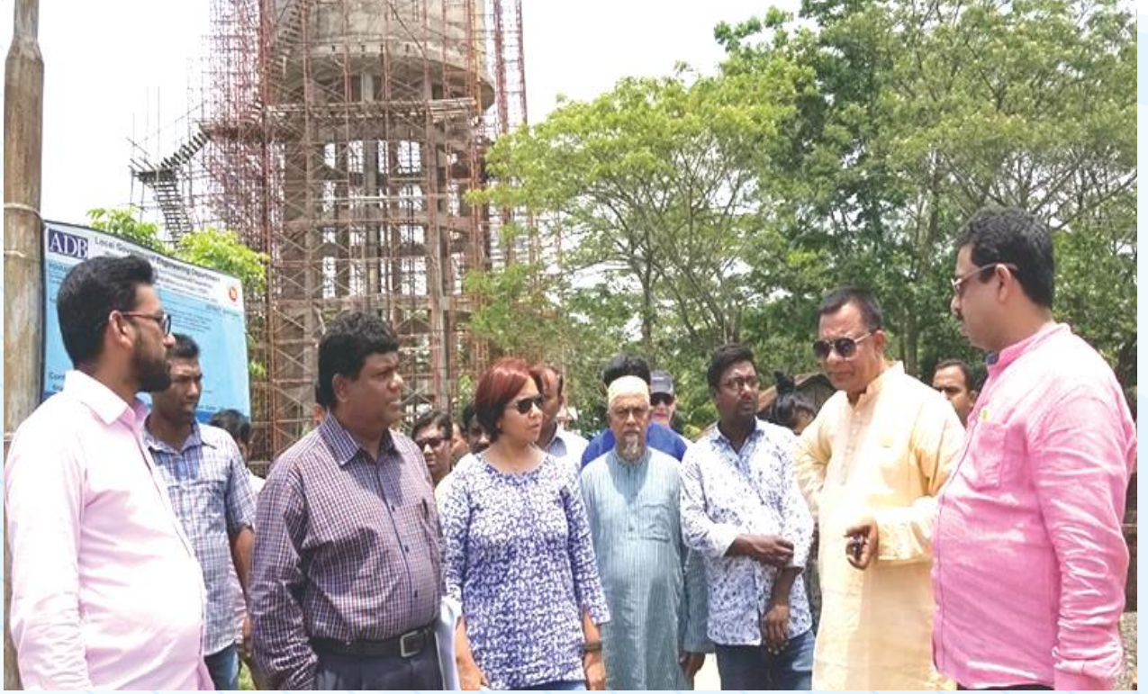
এডিবি মিশন বরগুনা জেলার আমতলী উপজেলায় ওভারহেড ট্যাংক নির্মাণ কাজ পরিদর্শন করছেন।
