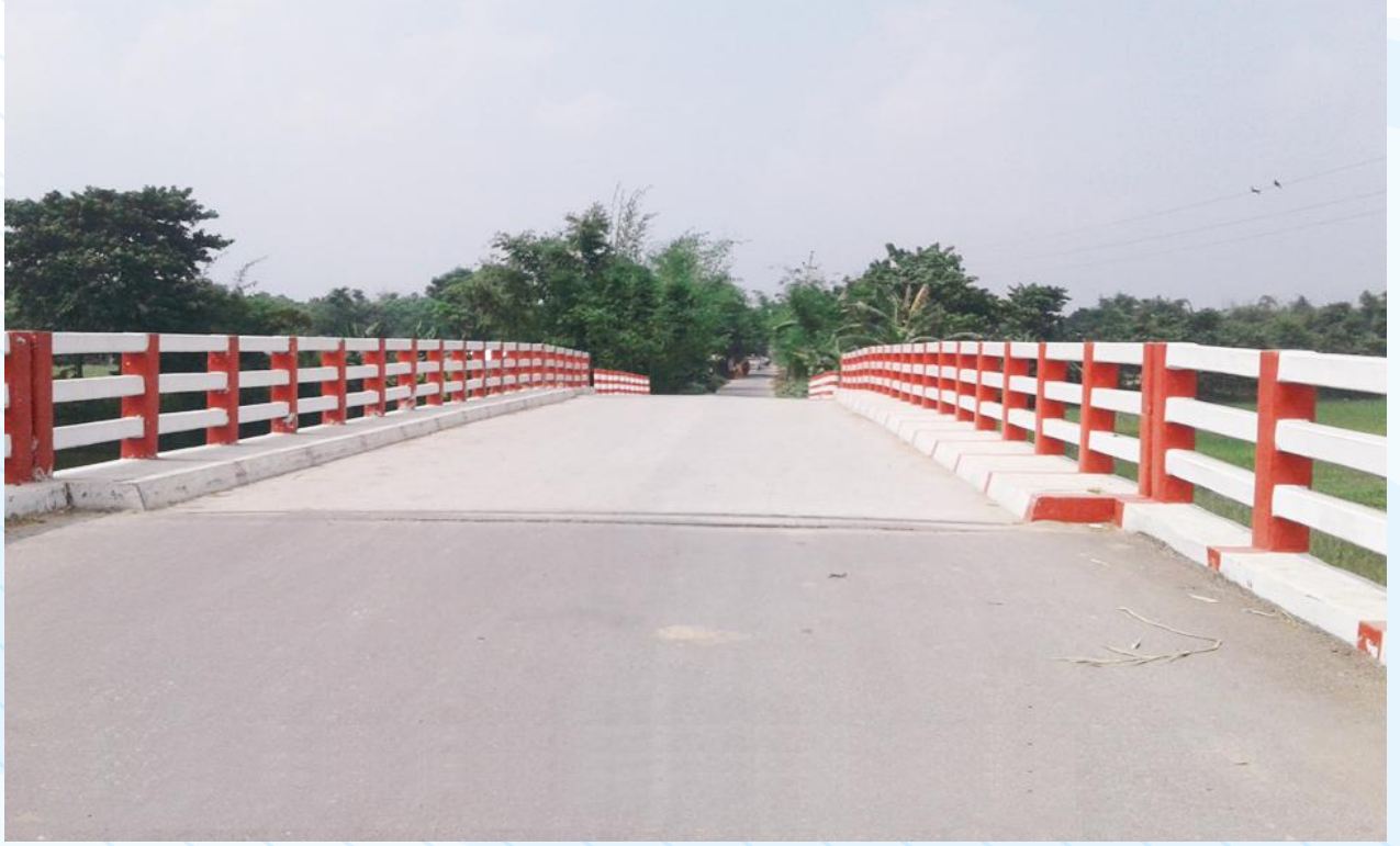
নবিদেপ, এলজিইডি কর্তৃক নির্মিত নীলফামারী জেলার সদর উপজেলাধীন কচুকাটা বন্দর থেকে নীলফামারী ডোমার সড়ক ও জনপথ ভায়া রামগঞ্জ রাস্তার উপর ২০ মিটার দীর্ঘ আরসিসি গার্ডার ব্রিজ
