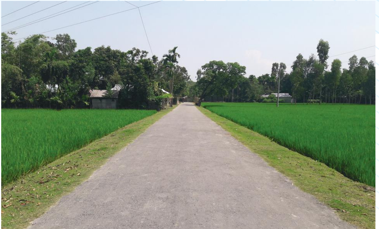
কুড়িগ্রাম জেলার রাজার হাট উপজেলাধীন নাজিমখান জিসি থেকে রতিগ্রাম জিসি ভায়া দনগারহাট সড়ক
