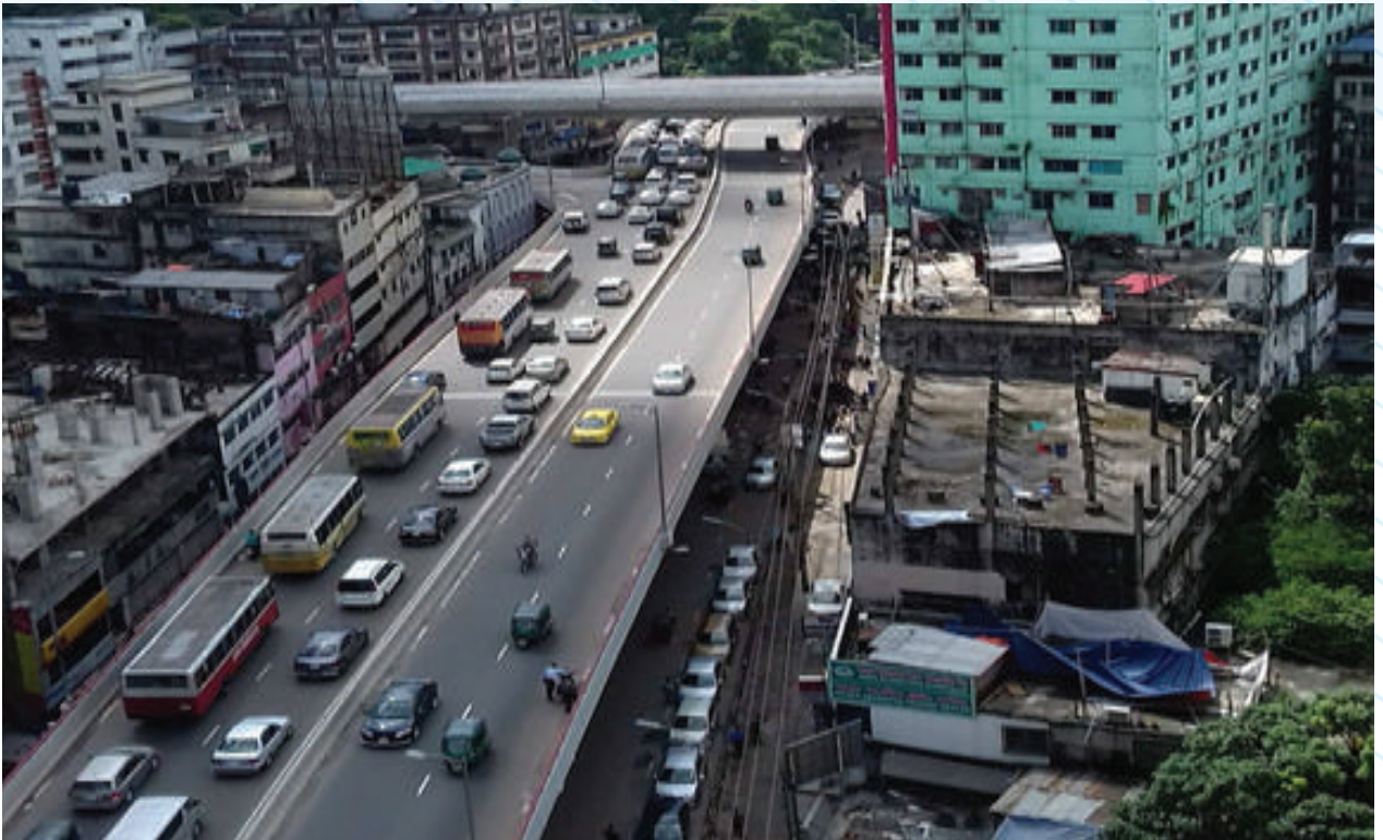
মগবাজার-মৌচাক ফ্লাইওভার এর মগবাজার মোড় ইন্টারসেকশন
