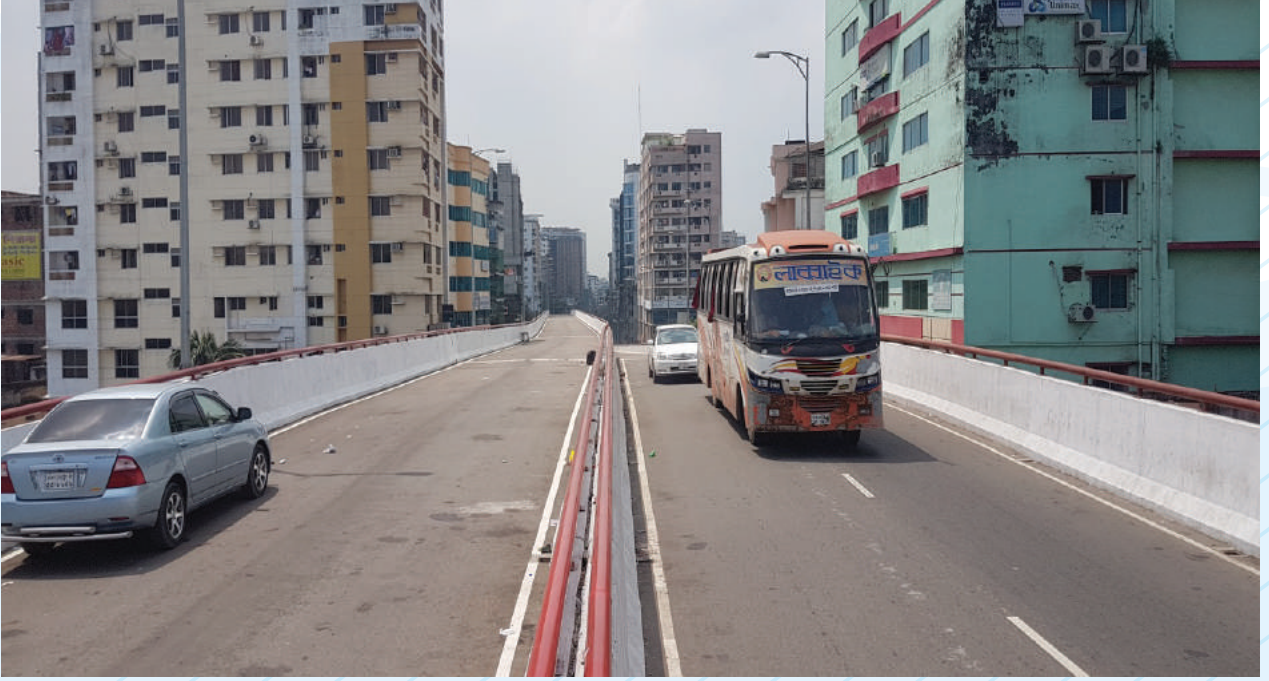
মগবাজার-মৌচাক ফ্লাইওভার এর বাংলামটর থেকে ওয়্যারলেস গেট অংশ
