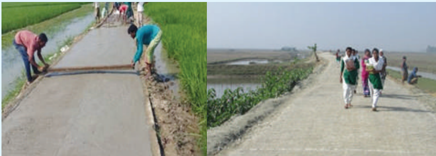
ডুবো সড়ক নির্মাণ কাজে ব্যস্ত শ্রমিকেরা
