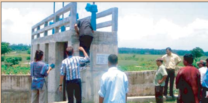
যৌথ পরিদর্শন মিশনের বাঘাবিল উপপ্লব কল্পের অবকাঠামো পরিদর্শন।
