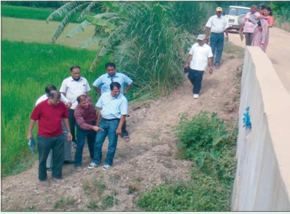
যৌথ মিশনের সদস্যবৃন্দ উপ-প্রকল্পের অবকাঠামো পরিদর্শন করছেন।
