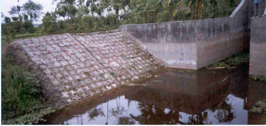
চিত্র-৩৫ ঢাল রক্ষাকারী ব্লকের গ্যাপ সঠিকভাবে খোলা রয়েছে (পিছনের পানি বের হয়ে যেতে পারে)
