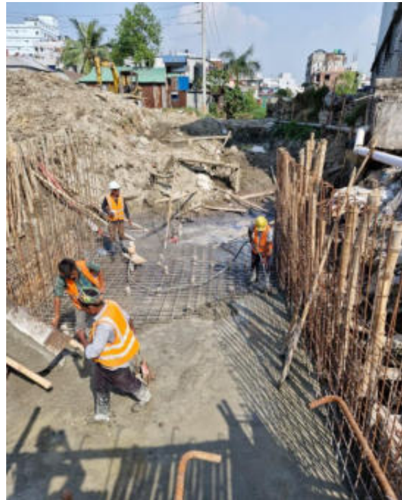
RCC U Drain base casting work, Kaliakoir Pourashava - W-01
