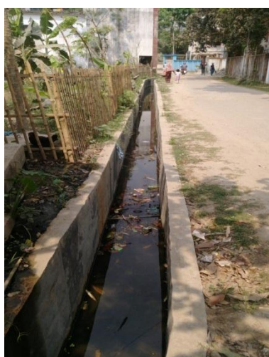
Drain: Magura Pourashava
