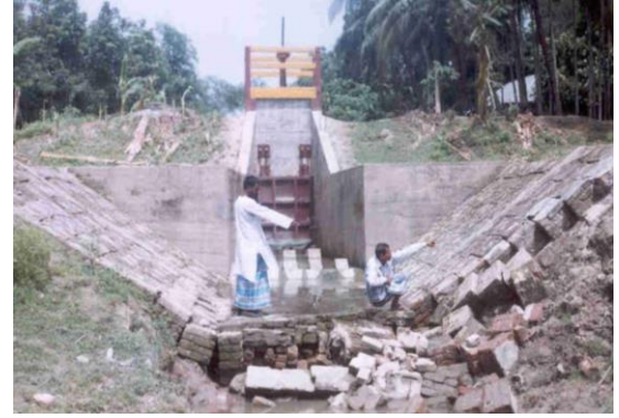
চিত্র-২৯ স্লোপ প্রোটেকশন এর ক্ষতি
