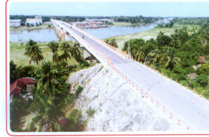
যশোর জেলার অভয়নগর উপজেলায় সড়ক ও জনপথের যশোর-খুলনা সড়কের ভাঙ্গাপেট (বাদামতলা) থেকে আমতলা জিসি ভায়া মরিচা, নাইশী বাজার সড়কে জৈরব নদীর ওপর ৭০২.৫৫ মিটার দীর্ঘ সেতু
