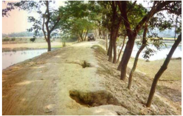
চিত্র-২৯ বাঁধে গাড়ীর চাকা ও ধসের গর্ত
