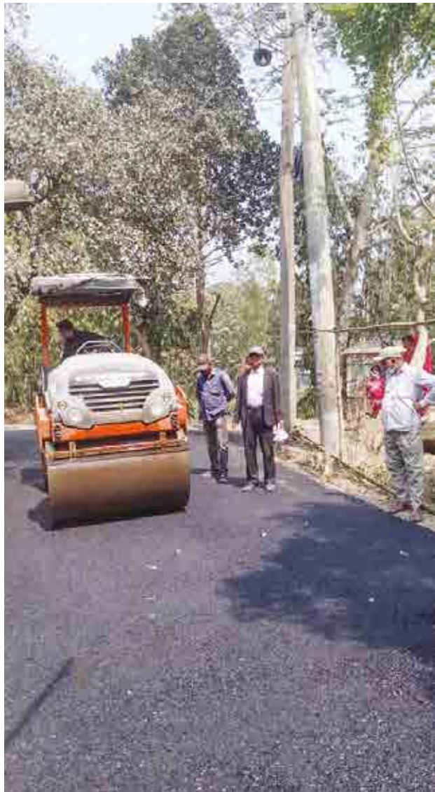
ছক ৬.৩: জুলাই ২০২১- জুন ২০২২ সময় মরেজমিনে কাজ পরিদর্শন ও গৃহীত ব্যবস্থা
