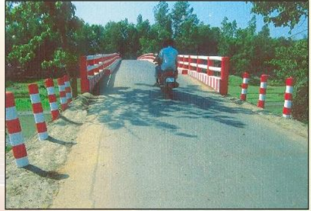
সড়ক এবং কালভার্ট রক্ষণাবেক্ষণের পর কুড়ালিয়া - দিঘলবাইদ সড়ক, উপজেলাঃ মধুপুর, জেলাঃ টাঙ্গাইল।
