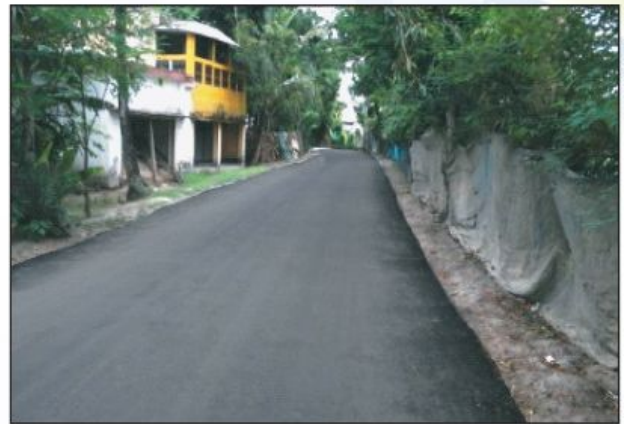
সমাস্তর রক্ষণাবেক্ষণ-পরবর্তী তালতলা আরএন্ডএইচ- পায়রা জিসি সড়ক, উপজেলাঃ অভয়নগর, জেলাঃ যশোর।
