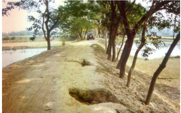
চিত্র-২৯ বাঁধে গাড়ীর চাকা ও ধসের গর্ত
