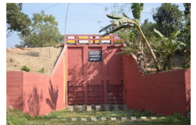
চিত্র-২৭ নবগঙ্গা খাল উপ-প্রকল্পে বাস্তবায়িত রেগুলেটর
