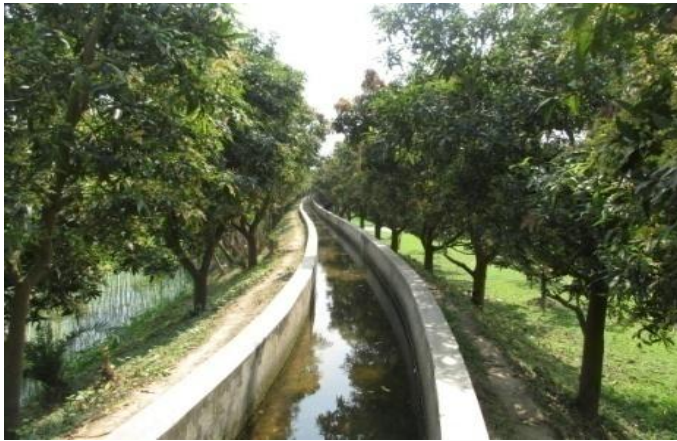
চিত্র-৯ অগ্রণী সেচ এলাকা উন্নয়ন উপ-প্রকল্পে বাস্তবায়িত পাকা সেচ নালা
