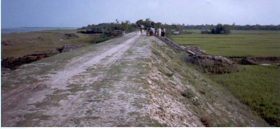
চিত্র-২০ বাঁধের ঢালে কোন ঘাস (টার্ফিং) লাগানো হয়নি (এমনিতে গজানো হালকা ঘাস মাটি ধুয়ে যাওয়া রোধ করতে পারে না)
