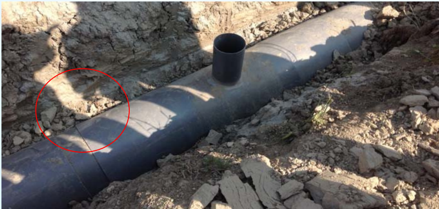
চিত্র-৪০ ভূ-গর্ভস্থ পিভিসি পাইপ লাইনের জয়েন্ট
