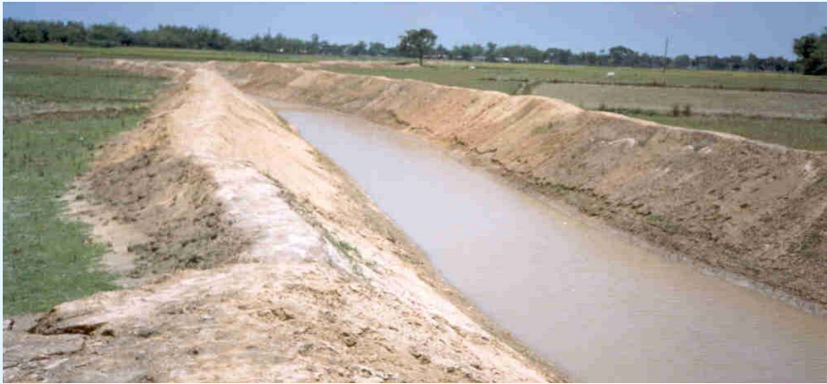
চিত্র-২২ খালের পুনঃখনন সমাপ্ত হয়েছে
