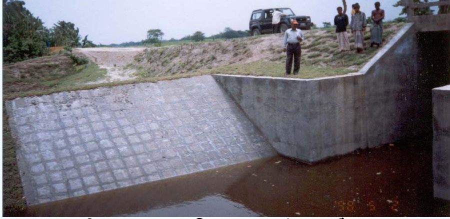
চিত্র-৩৬ ঢাল রক্ষাকারী ব্লকের গ্যাপ প্রাঙ্গার করা ঠিক নয় (পিছনের পানি আটকে পড়ে চাপ সৃষ্টি করে, ব্লকের স্থিতি দুর্বল হয়)
