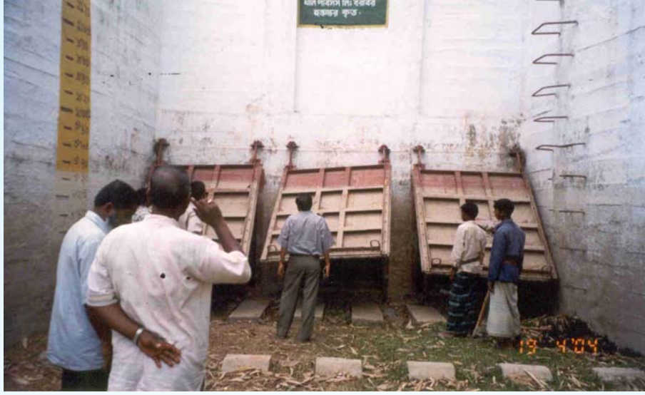
চিত্র-২৬ ফ্ল্যাপ গেইট আংশিক তোলা অবস্থায় (অনেক সময় পানি নদী থেকে ভিতরে ঢোকানোর জন্য ফ্ল্যাপ গেইট তুলতে হয়)
