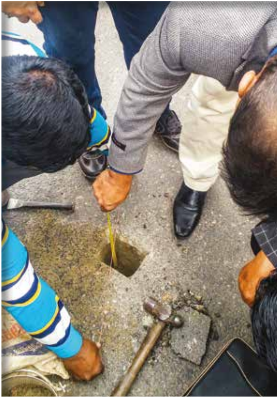
পরিদর্শন দলের কর্মীরা সড়কের কাপেটিং স্তরের পুরুত্ব পরিমাপ করছেন
