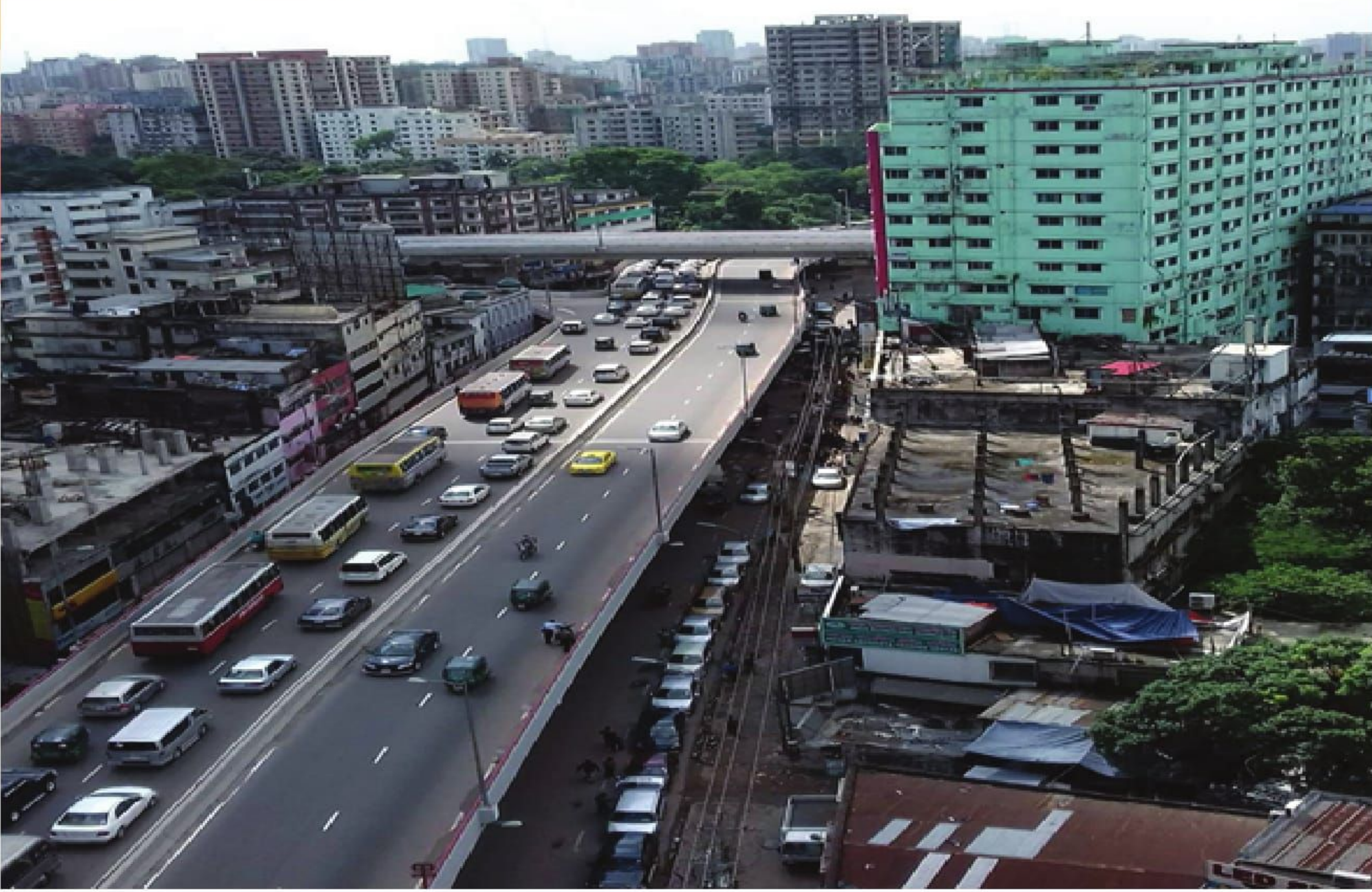
মগবাজার-মৌচাক ফ্লাইওভার এর মগবাজার মোড় ইন্টারসেকশন
