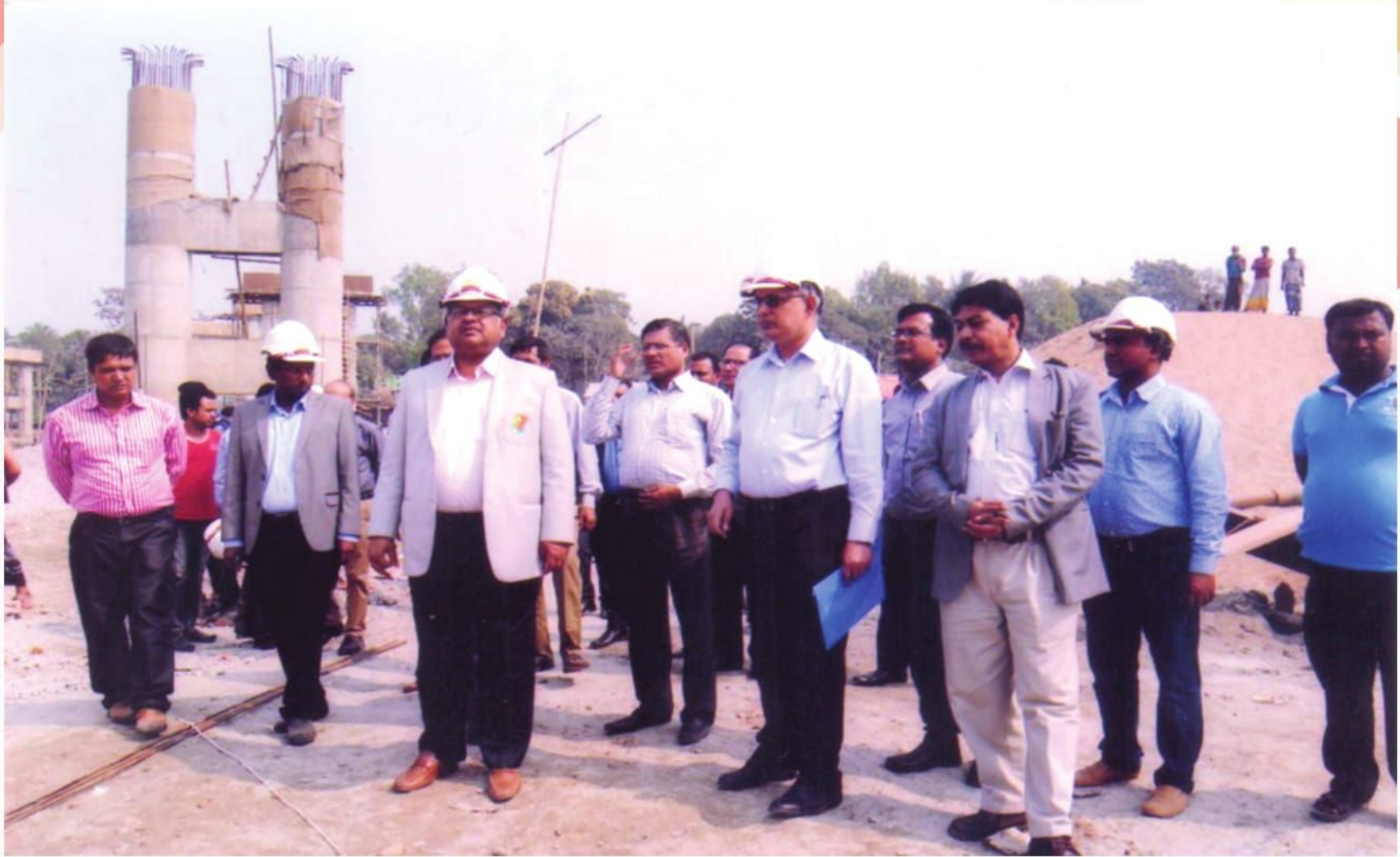
১১ ফেব্রুয়ারি ২০১৭ তারিখে এলজিইডি'র প্রধান প্রকৌশলী জনাব শ্যামা প্রসাদ অধিকারী ব্রাহ্মণবাড়িয়া জেলার নবীনগর উপজেলার গোকর্ণা লঞ্চঘাটে তিতাস নদীর ওপর নির্মাণাধীন ৫৭৫ মিটার দীর্ঘ সেতুর নির্মাণ কাজ পরিদর্শন করছেন।
