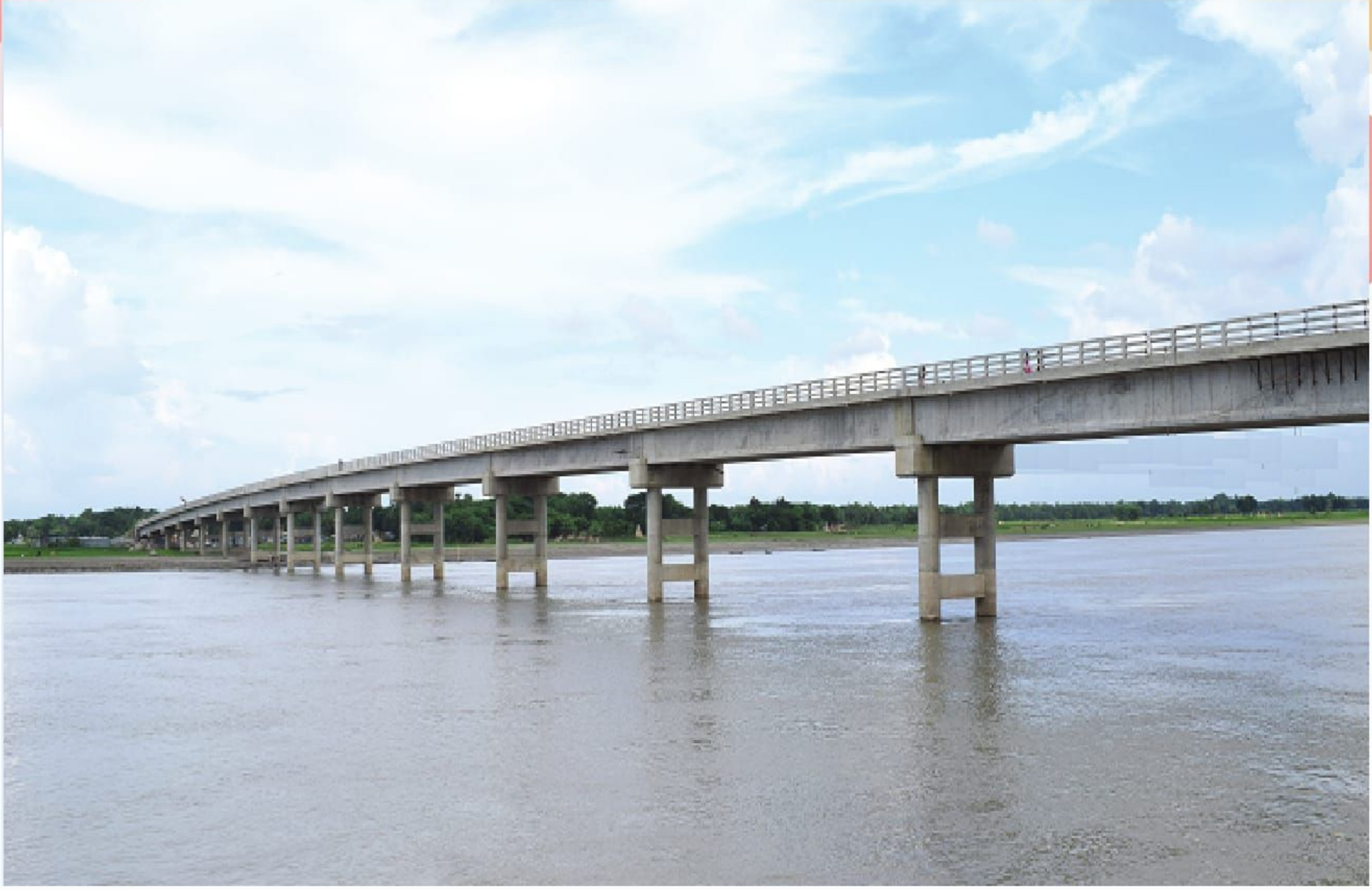
মাগুরা জেলার মোহাম্মদপুর উপজেলা হেড কোয়ার্টার-রাউজানী আরএন্ডএইচ সড়কে মধুমতি নদীর উপর নির্মিত ৬০০.৭০ মিটার দীর্ঘ ব্রিজ
