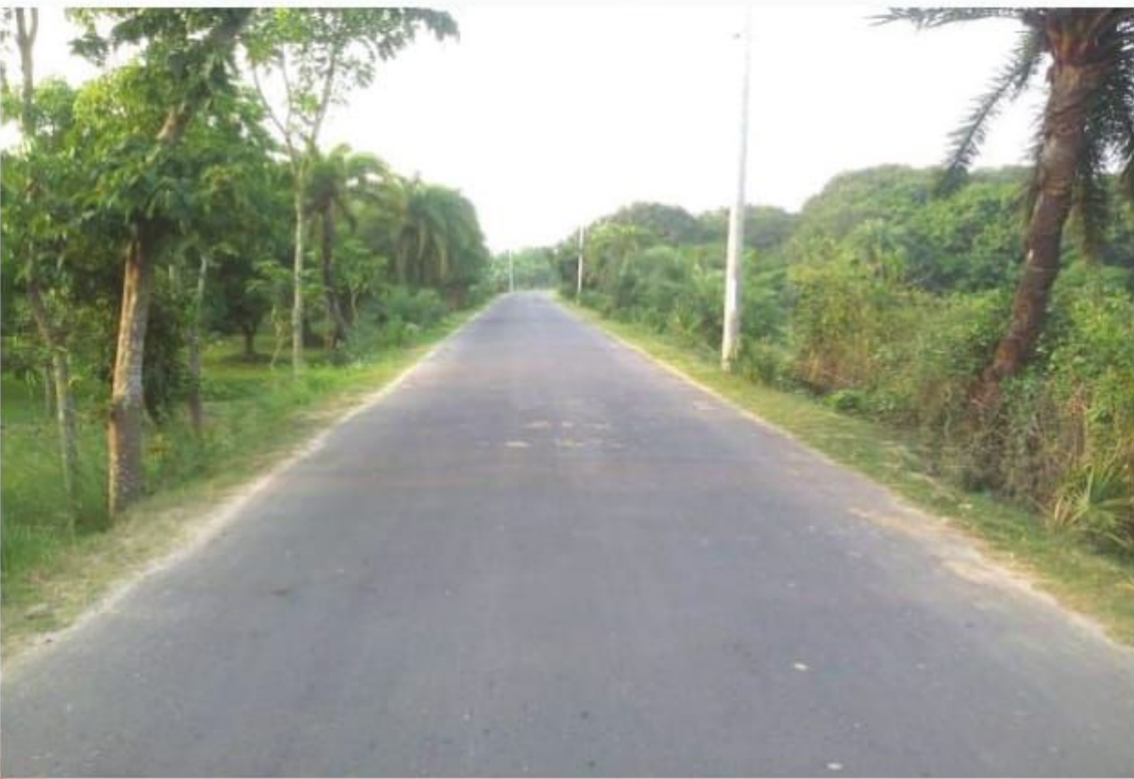
[রক্ষণাবেক্ষণের পর] মাগুরা - বুনাগাতি জিসি সড়ক উপজেলাঃ মাগুরা সদর, জেলাঃ মাগুরা।
