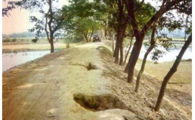
চিত্র-২৯ বাঁধে গাড়ীর চাকা ও ধসের গর্ত
