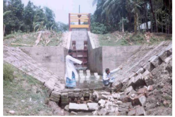
চিত্র-২৯ স্লোপ প্রোটেকশন এর ক্ষতি
