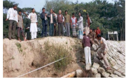
চিত্র-১৯ বর্ষার পর যৌথ পরিদর্শন
