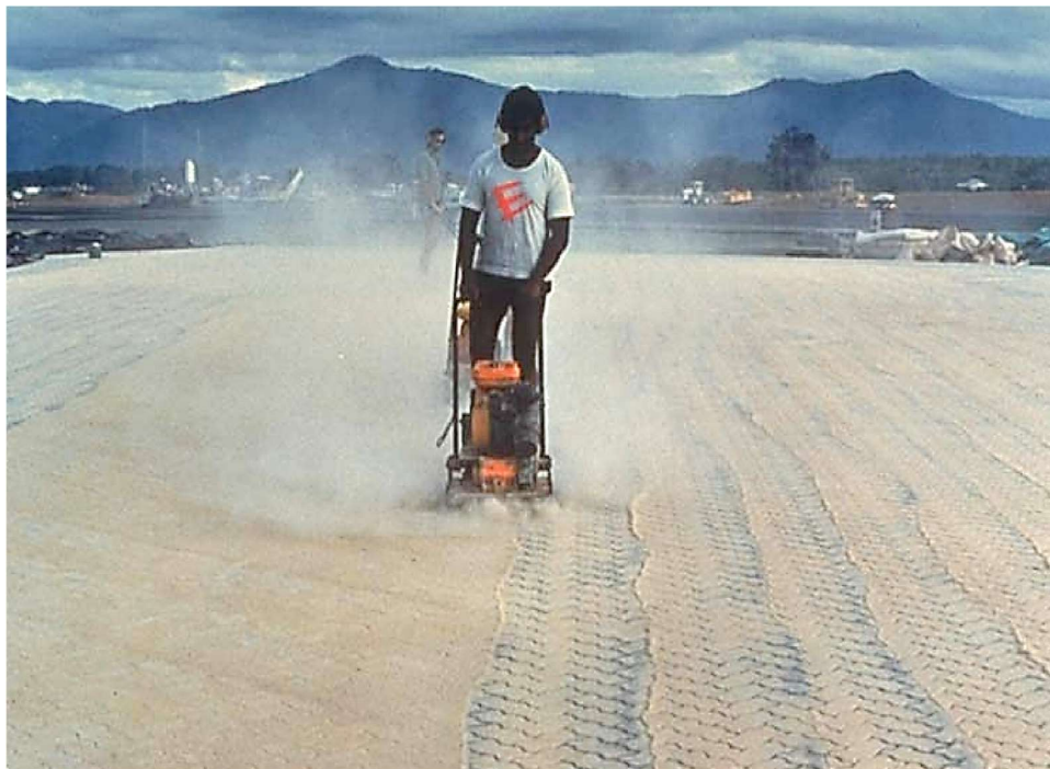
Filling Sand এর Compaction
